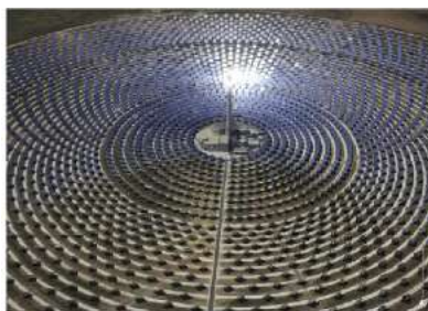
Slika 3.14. Gemasolar solarna elektrana sa poljem heliostata [59]
